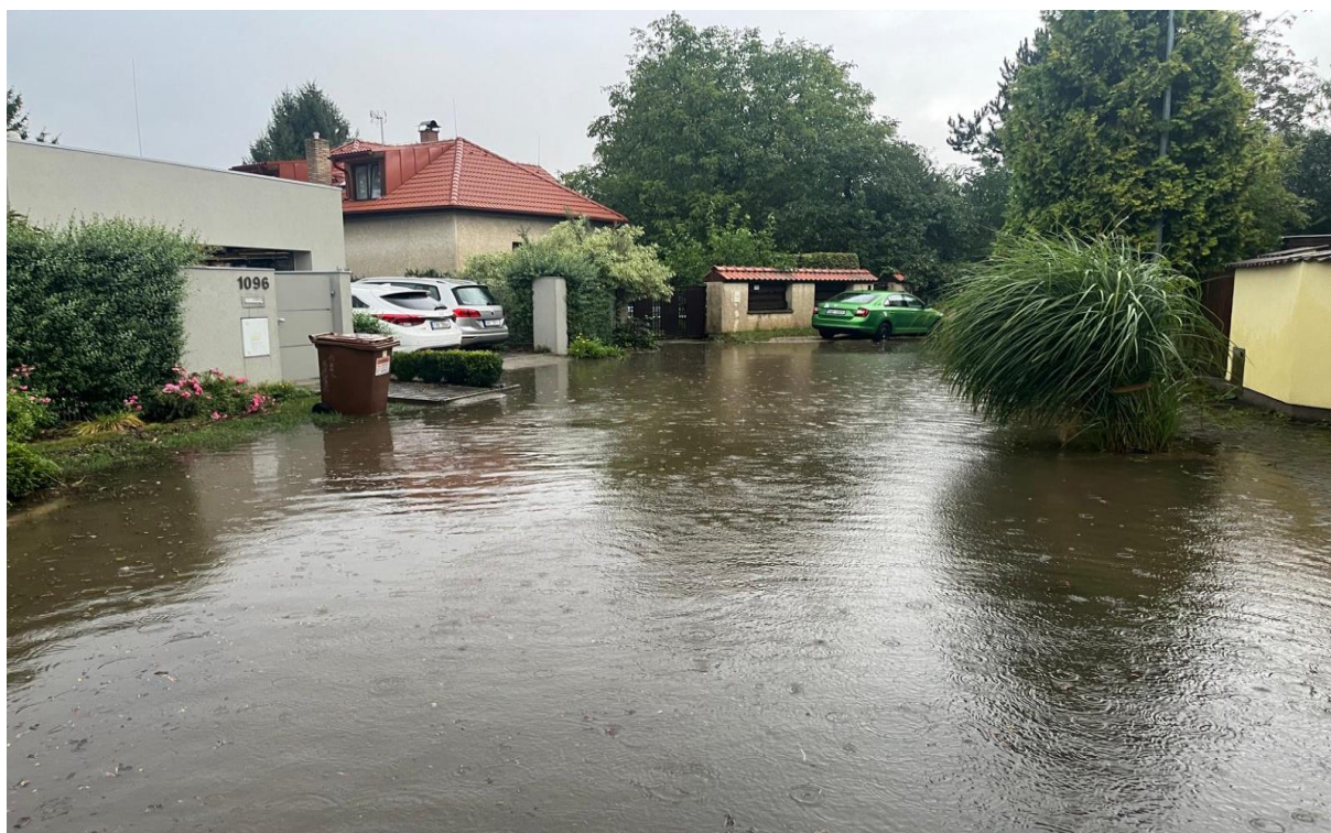
Zádražanská 18.8.2024 (pohled z Dohalické)
