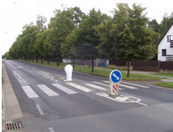
Obr.6 – Přechod pro chodce v jižní části ulice Slavětínská opatřený středovým ostrůvkem a optickými zklidňujícími prvky
