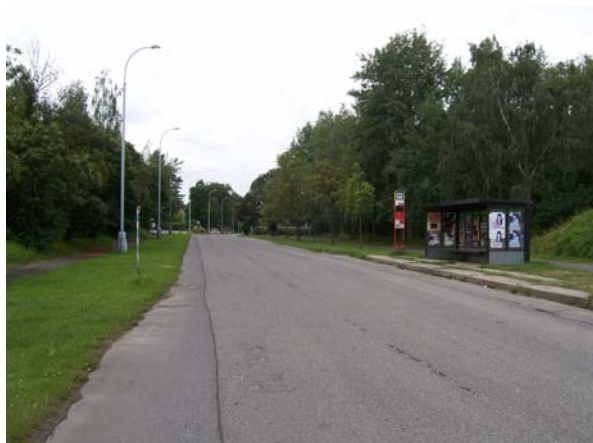
Obr.11 – Zastávka MHD v ulici Šlechtitelská s přístřeškem
