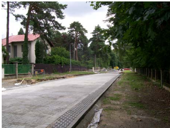
Obr. 15 – Část ulice V Soudním, která v současné době prochází rekonstrukcí
