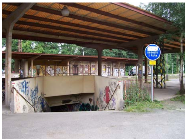
Obr.24 – Železniční stanice Praha - Klánovice
