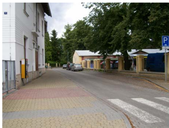
Obr. 19 – Parkovací pás v ulici Smržovská
