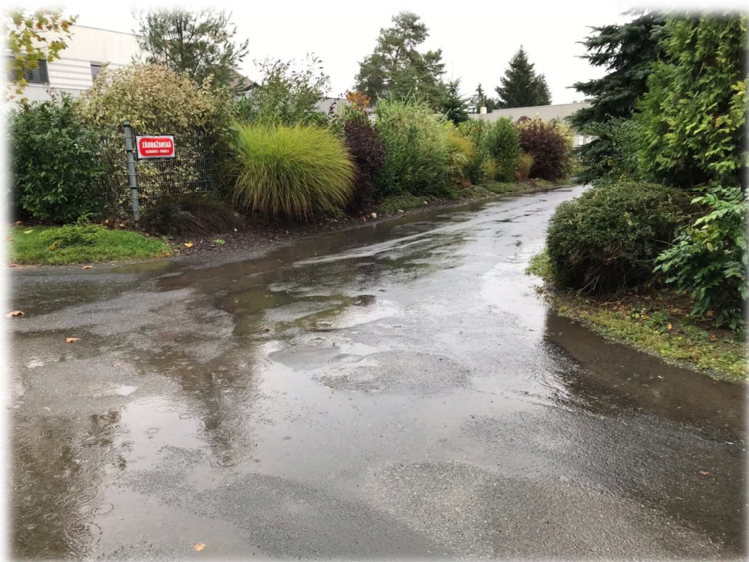
Obrázek 82: Zádražanská (pohled z křižovatky s ul. Dohalická 1)
