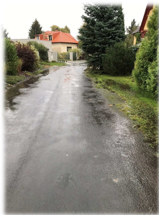
Obrázek 83: Zádražanská (pohled z křižovatky s ul. Dohalická 2)
