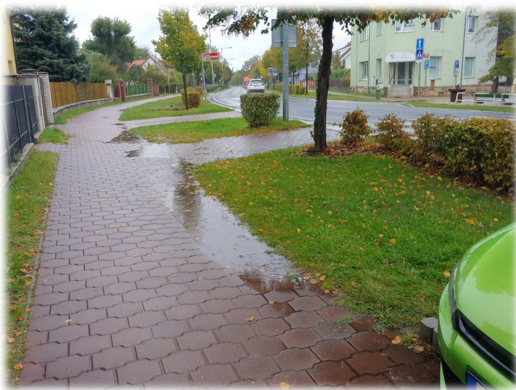
Obrázek 56: Slavěfinská (západní chodník, pohled od ul. Ke Kostelíčku do ul. Ke Znaku 3)
