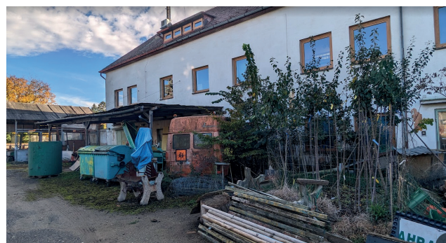
▲ Provozní budova v roce 2022.
