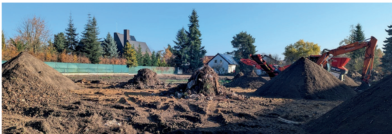
▲ K revitalizaci půdy byla použita těžká technika, včetně třídičky, která umožnila vyčistit půdu od odpadu přímo na místě.
