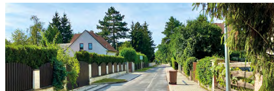
Rekonstrukci ulice Sendražická jsme „zdědili“ a až výměnou osob u investora i zhotovitele se projekt podařilo dotáhnout.
