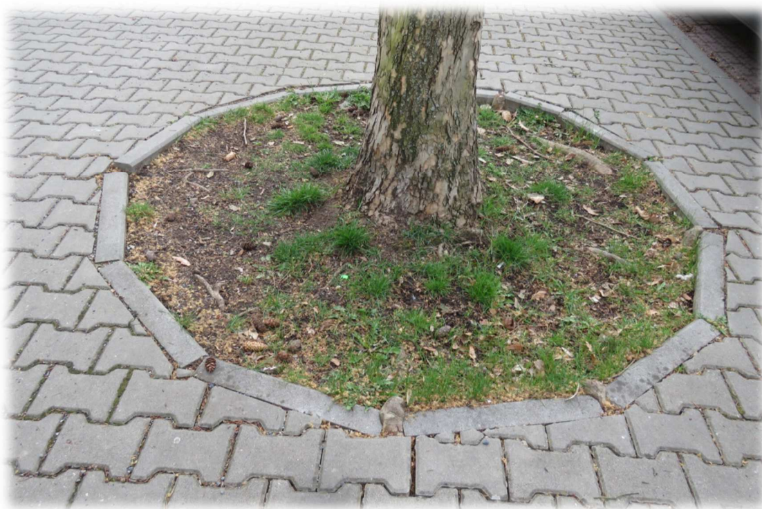
Obrázek 15: Zoufalý pokus vitálního platanu o únik z extrémně omezeného prostoru zcela disproporčního vůči potřebám dominantního stromu. Typický příklad ataku kufru cest stromem z důvodu jediného zdroje vzduchu. Nutné dimenzování adekvátního prokořenitelného prostoru, dostupnosti vzduchu a vody.
