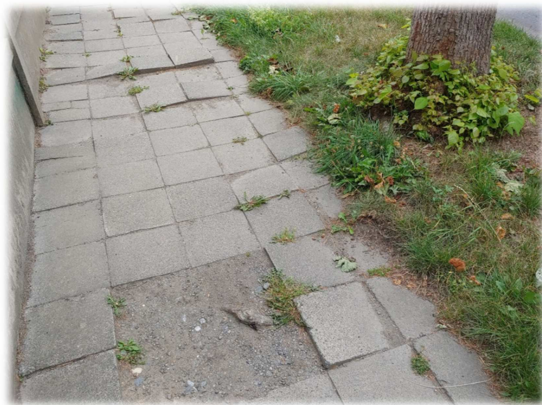
Obrázek 48: Chodník poškozený kořeny v ulici K Rukavičkárně
