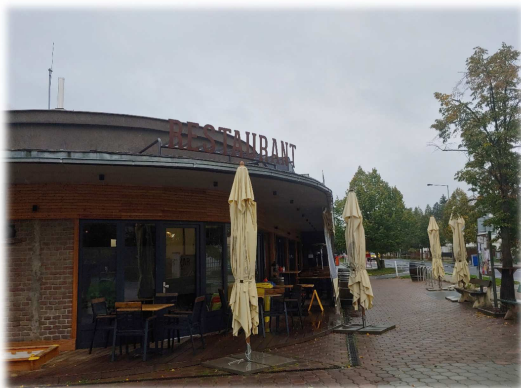
Obrázek 24: Objekt slavětínská 173 – restaurace bazar
