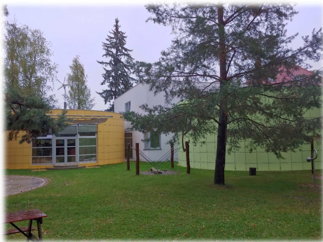
Obrázek 12: MŠ Klánovice – nová moderní budova s 2 učebnami kruhového půdorysu
