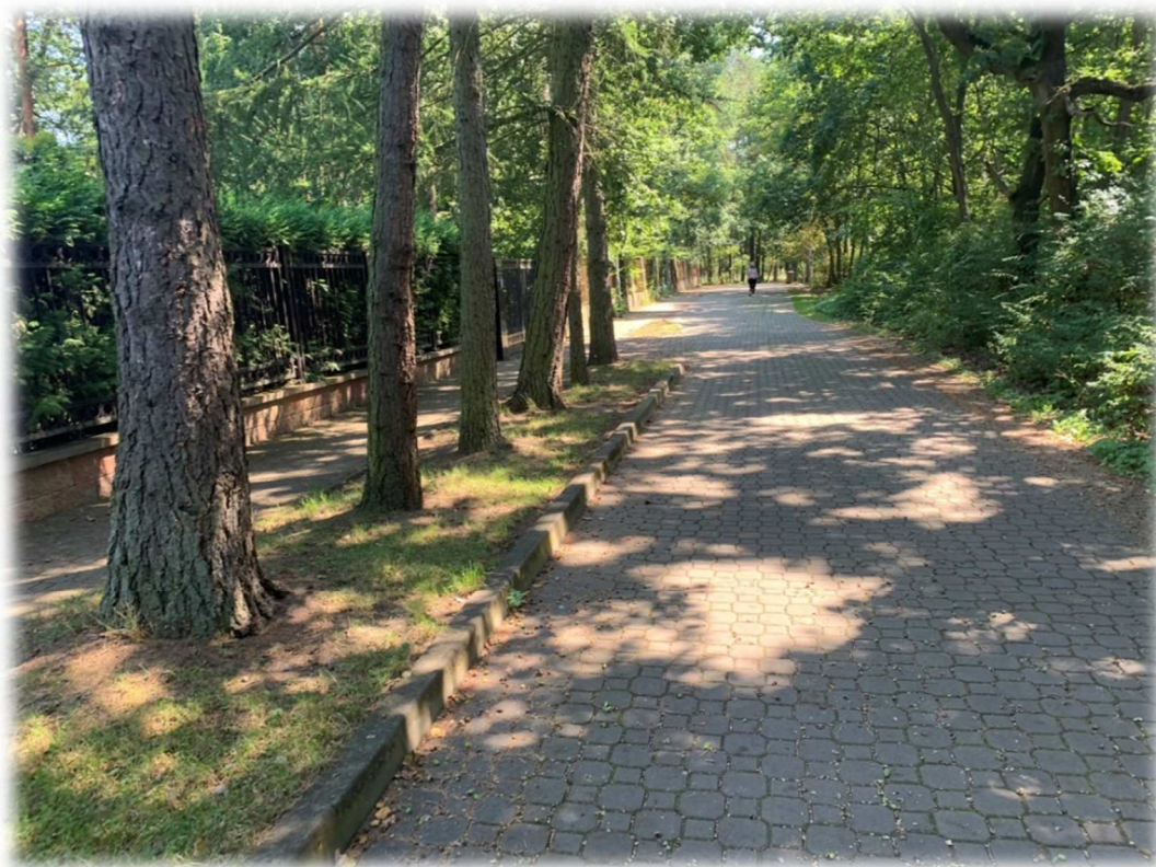
Obrázek 29: Lokální zvýšení obrubníku v ul. Habrovská (malé nedostatky)
