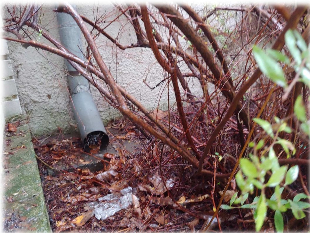
Obrázek 4: Dešťový svod do na budově technického zázemí úřadu MČ Praha – Klánovice, zaústěn do zeleně
