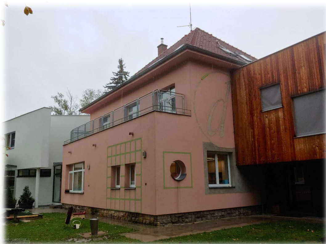
Obrázek 11: MŠ Klánovice – budova původní vily vpravo s dřevěnou přístavbou
