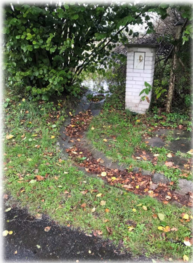
Obrázek 37: Bezpečnostní přeliv z retence na poli (ul. Podlíbská)
