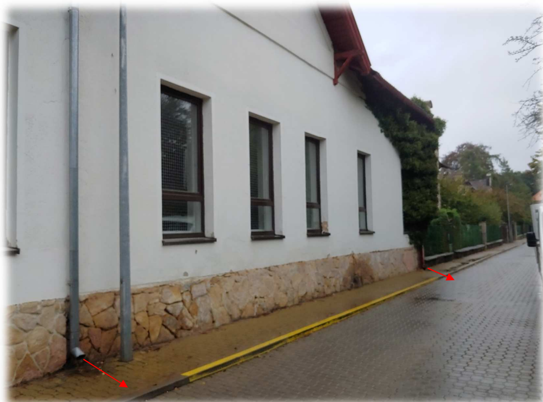
Obrázek 22: Dešťový svod na budově Nová Beseda v ulici U Běsedy
