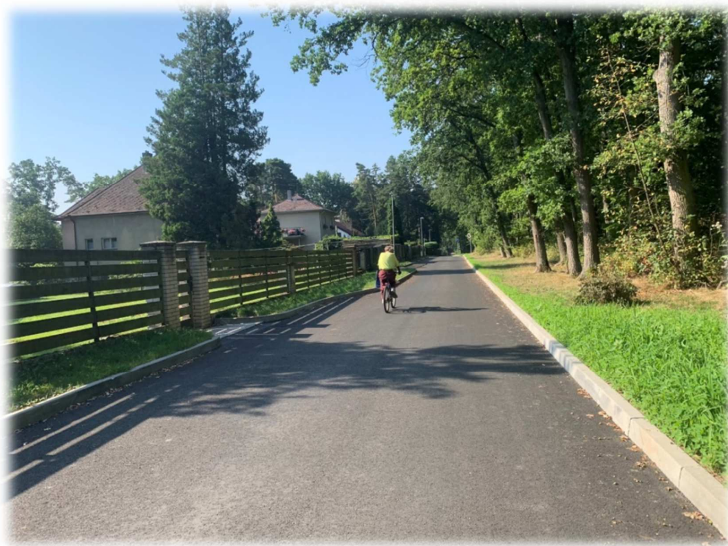
Obrázek 32: Nevhodné řešení uličního prostoru v ulici Blešnovská – zvýšený obrubník i směrem do lesu (problémy)
