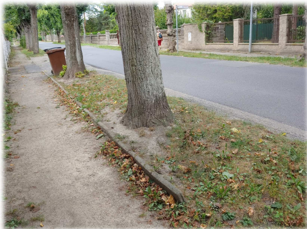
Obrázek 46: Chodník s mlatovým povrchem
