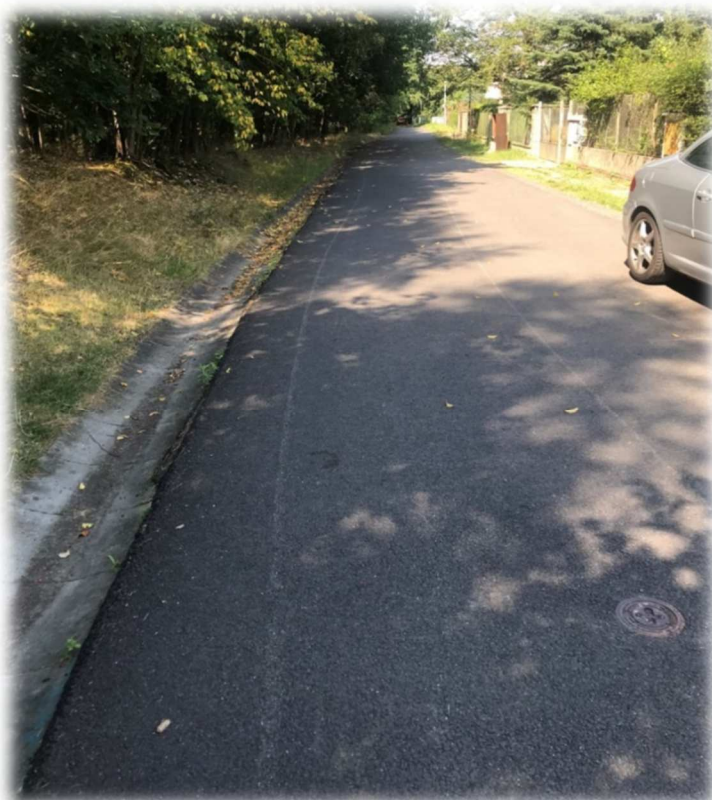
Obrázek 35: Povrchové odvodnění pomocí betonových žlabovek (ul. Srnečkova)
