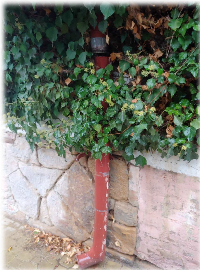
Obrázek 23: Rozbitý dešťový svod na budově Nová Beseda v ulici U Besedy
