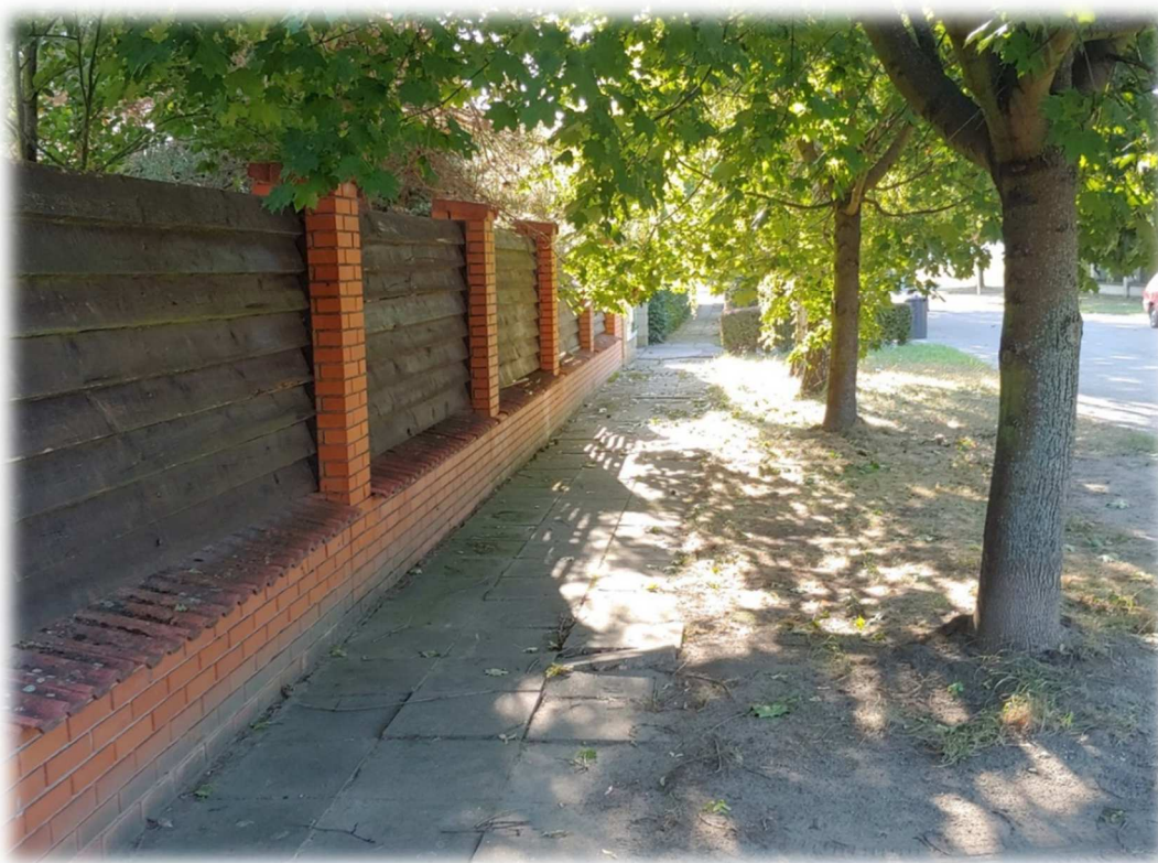
Obrázek 50: Chodník poškozený kořeny v ulici Riegrova
