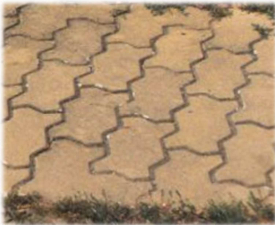
Obrázek 44: Betonová dlažba – chodník typ 3
