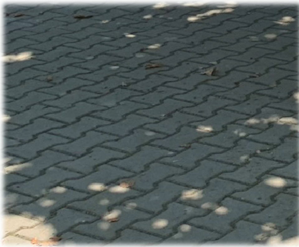
Obrázek 43: Betonová dlažba – chodník typ 2
