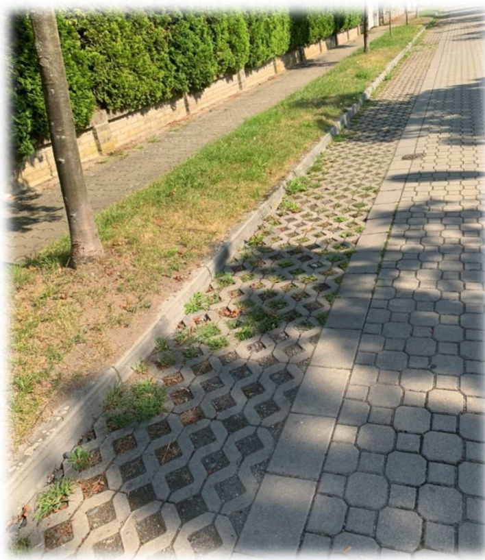
Obrázek 34: Vsakovací pás podél vozovky ze zatravnovacích betonových prvků (ul. Aranžérská)
