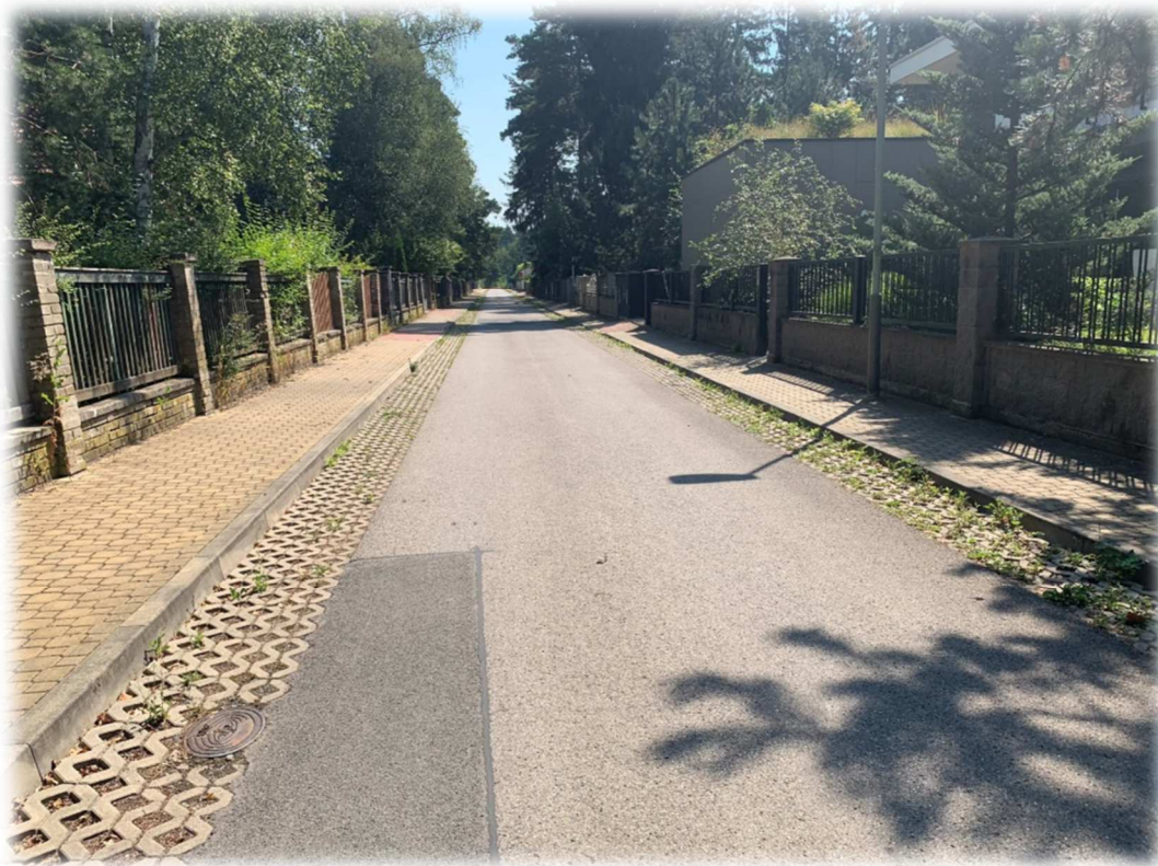
Obrázek 31: Ul. Lochenická – absence zeleně v uličním prostoru, voda z komunikace vsakována do pásů ze zatravnňovací dlažby (závažné nedostatky)
