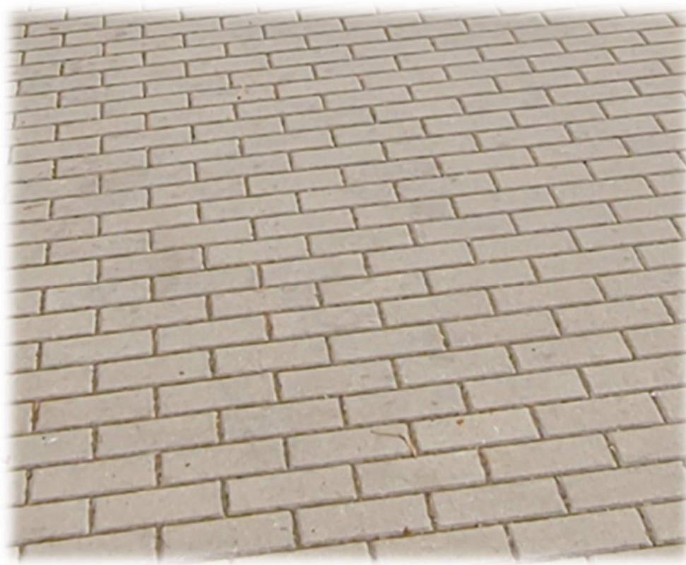
Obrázek 39: Betonová dlažba – vozovka typ 2
