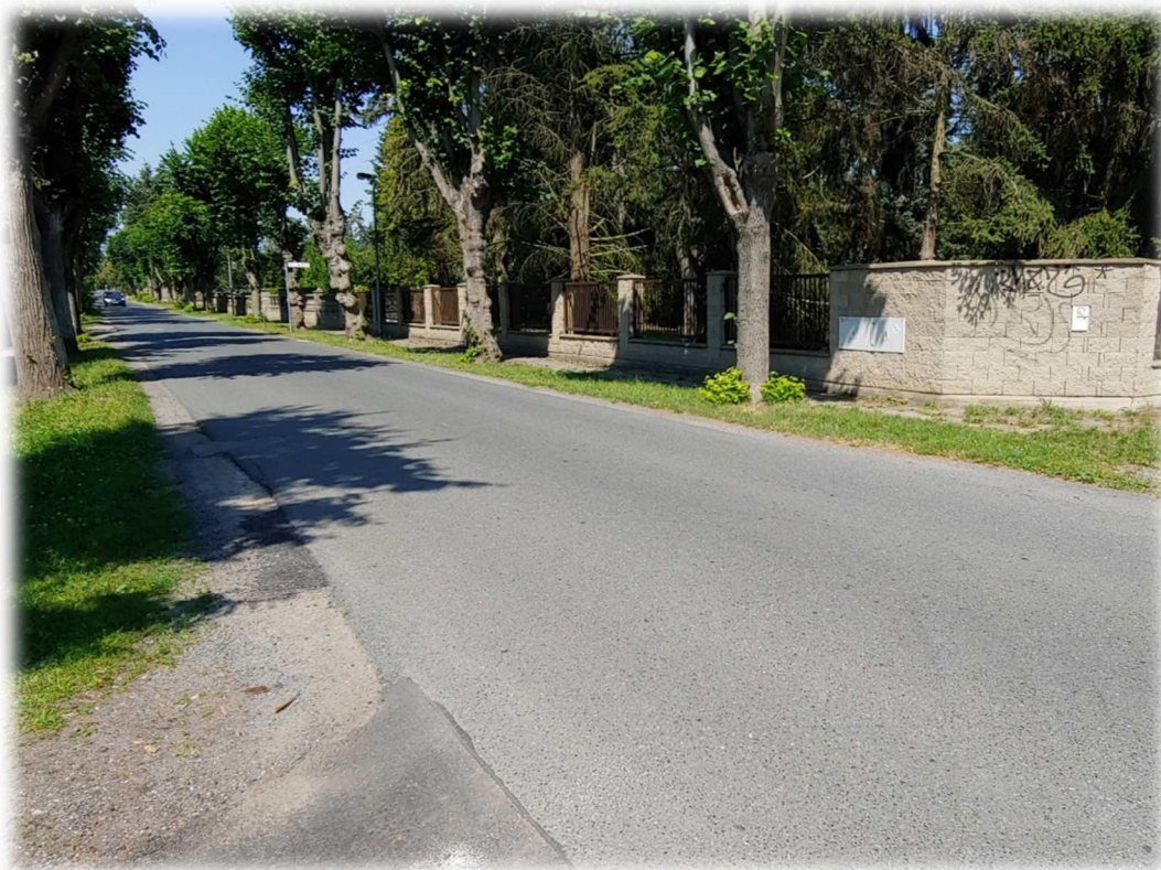
Obrázek 40: Asfaltový povrch vozovky
