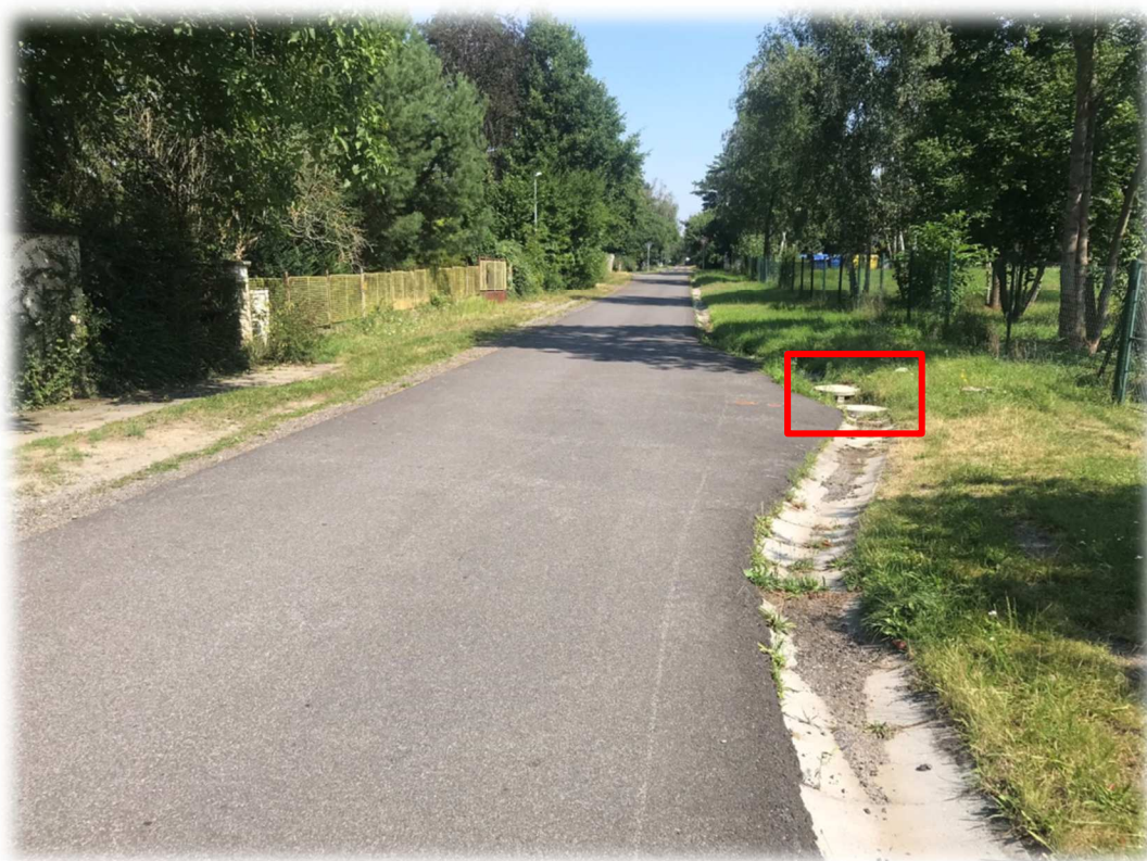
Obrázek 36: Povrchové odvodnění pomocí betonových žlabovek a zaústění do Šestajovického potoka (ul. Vodojemská)
