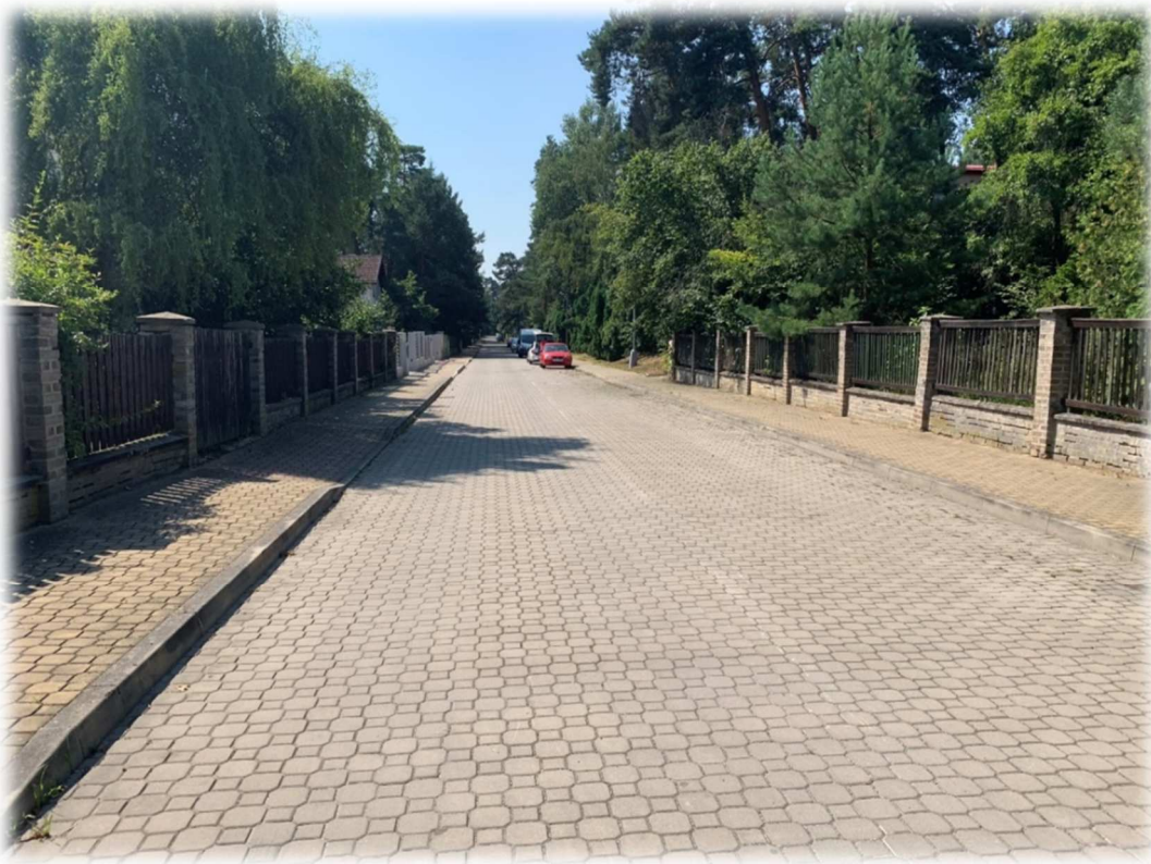
Obrázek 33: Nevhodné řešení úseku uličního prostoru v ulici Medinská – absence zeleně, veškerá srážková voda je svedena do dešťové kanalizace (problémy)
