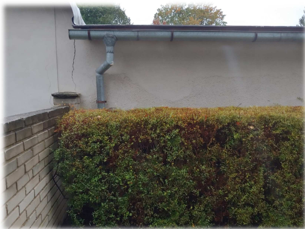
Obrázek 3: Dešťový svod do na budově technického zázemí úřadu MČ Praha – Klánovice, zaústěn do zeleně
