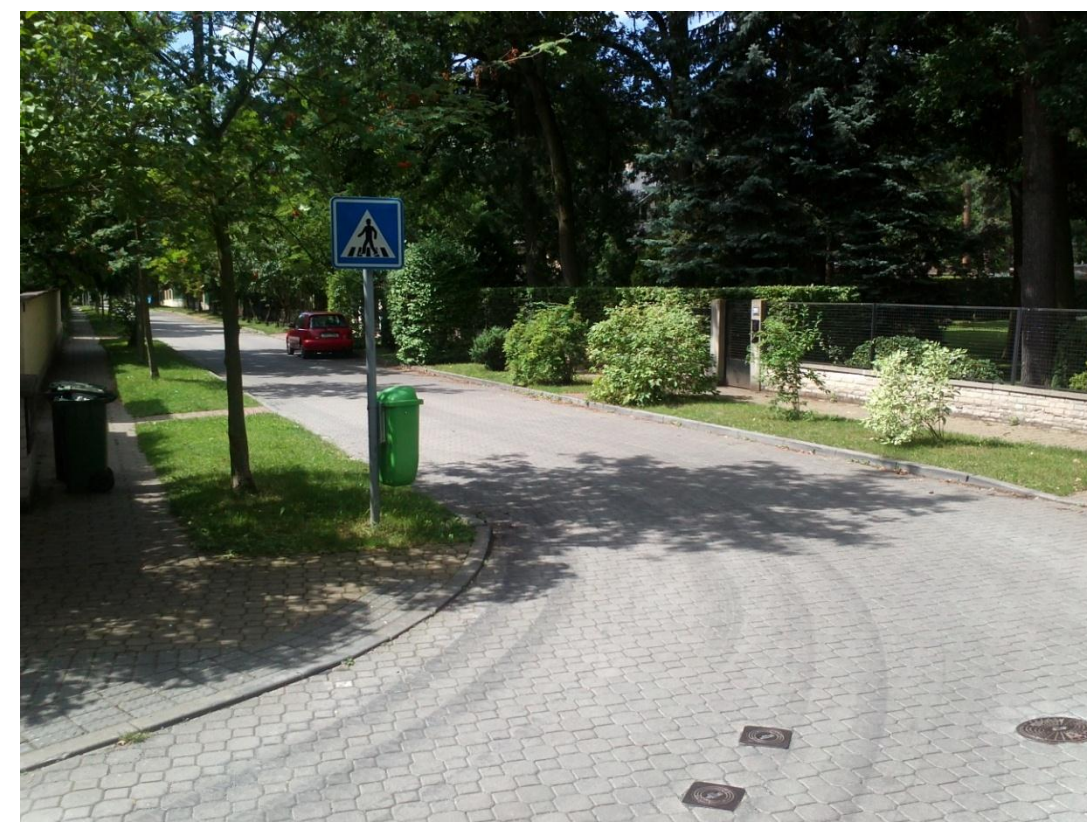
Svislé dopravní značení IP 6 umístěné za přechodem pro chodce. Vodorovné dopravní značení označující přechod pro chodce je téměř neviditelné.
