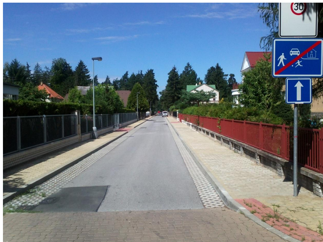
Nově rekonstruované komunikace se zatravnovací dlažbou pro odtok dešťové vody. Vzhledem k úzkým jízdním profilům jsou ulice zjednosměrněny a zařazeny do zóny TEMPO30.
