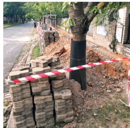
Rekonstrukce na Medinské již začala
