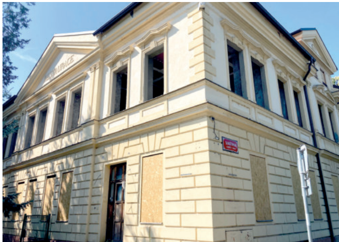
Současný stav objektu U Daschů. F
